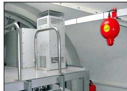
Naši iznimno kompaktni generatori aerosola zbog svog trodimenzionalnog efekta gašenja se mogu ugraditi u male prostore te koristiti kao trajno i pouzdano sredstvo i pod najtežim radnim uvjetima.
