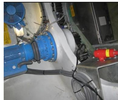
Aktiviranje može biti ručno i/ili automatski sa električnom ili termičkom pobudom. Najjednostavnija varijanta sustava se sastoji od generatora sa termičkom pobudom. Takav sustav može raditi potpuno autonomno, bez napajanja električnom energijom.
